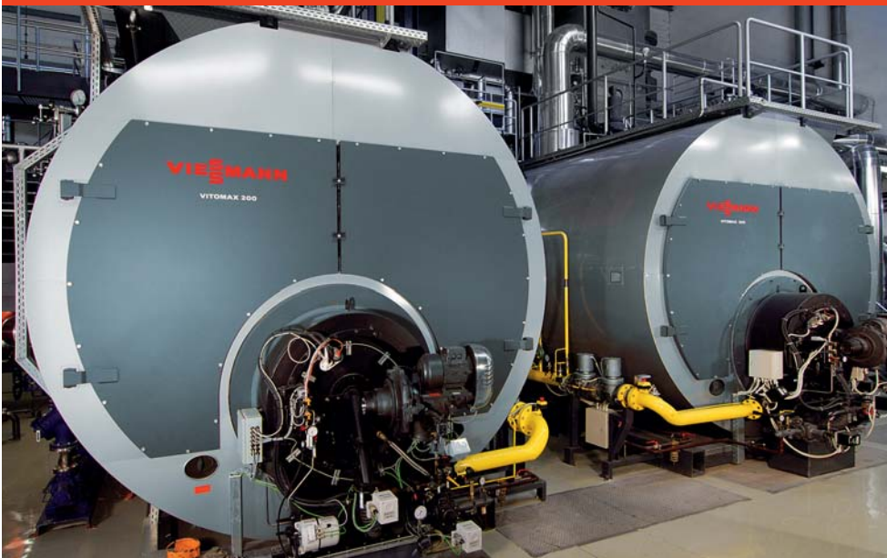
Abb. B.1.3-1 Dampfkesselanlage
