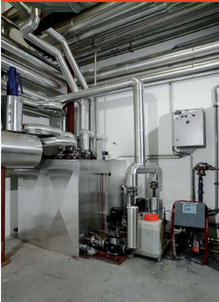
Abb. C.6.1-1 Kondensatbehälter
