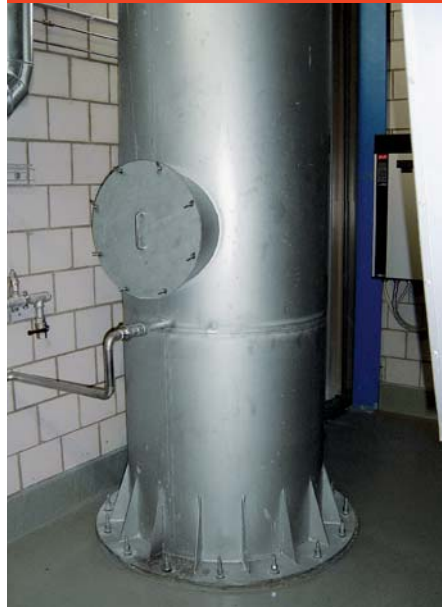
Abb. D.9.4-5 Schornsteinfuß
