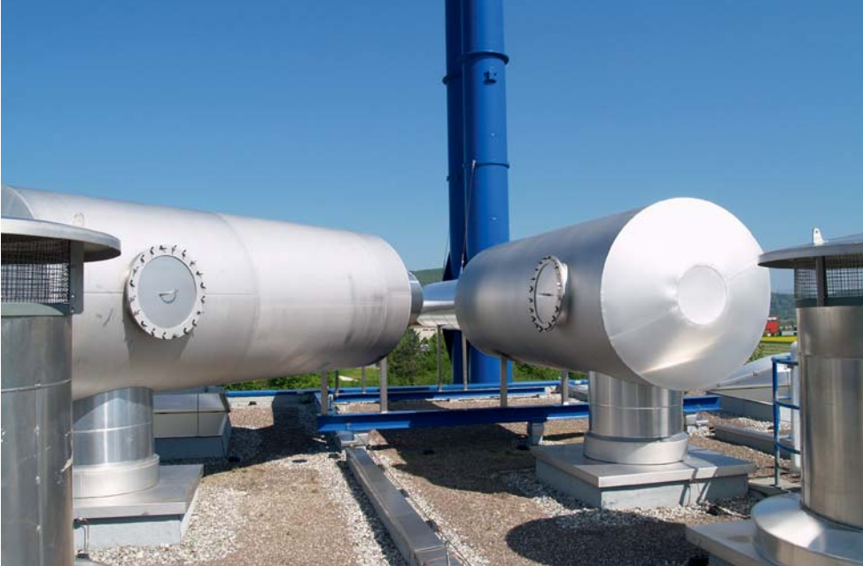
Abb. C.10-2 Abgasschalldämpfer Dampfanlage
