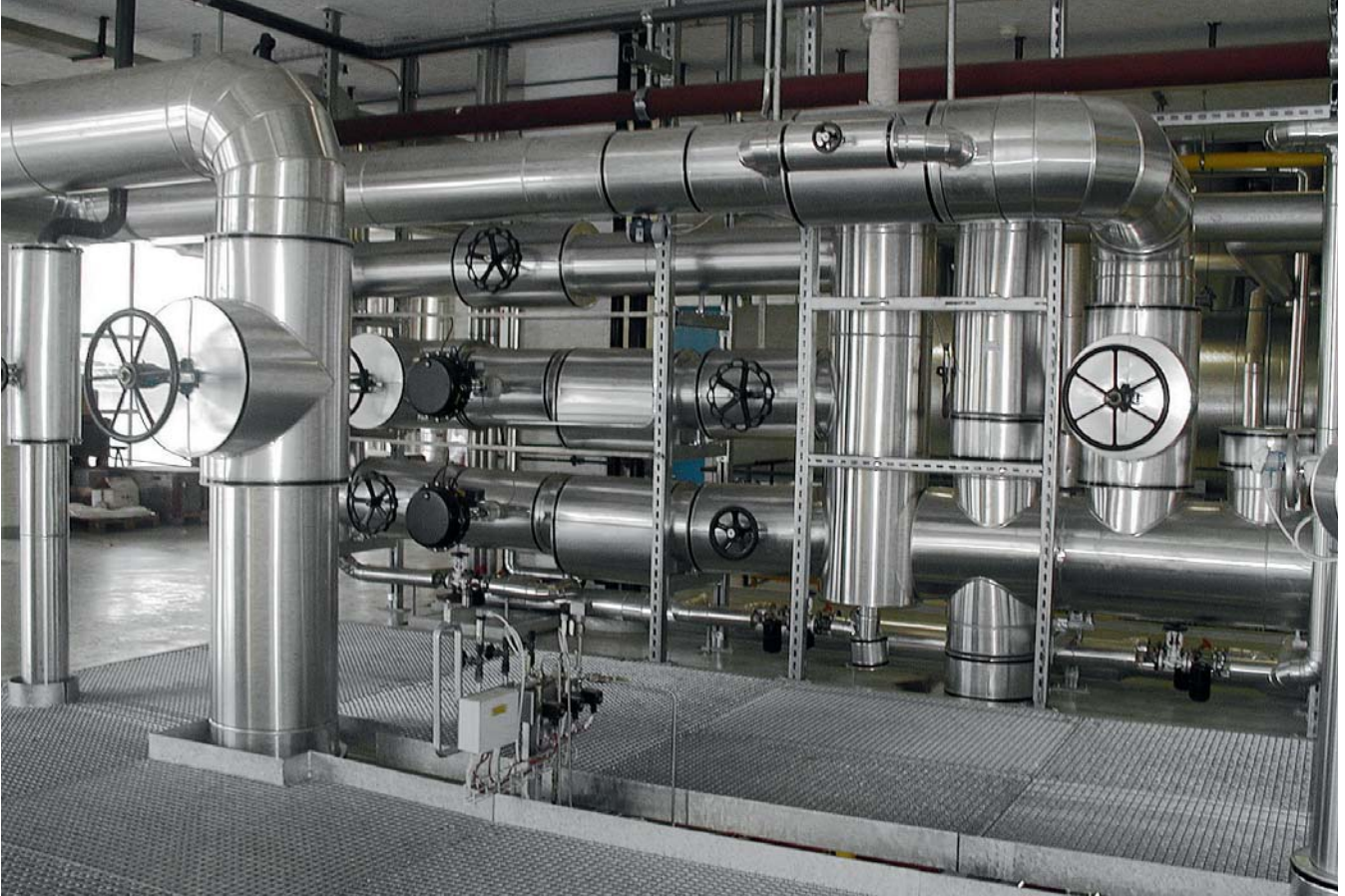
Abb. C.9-1 Hauptdampfleitung
