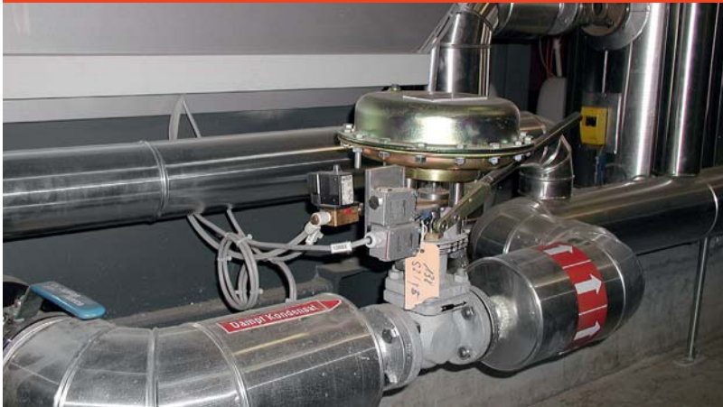
Abb. C.1.1-4 Abschlammentil
