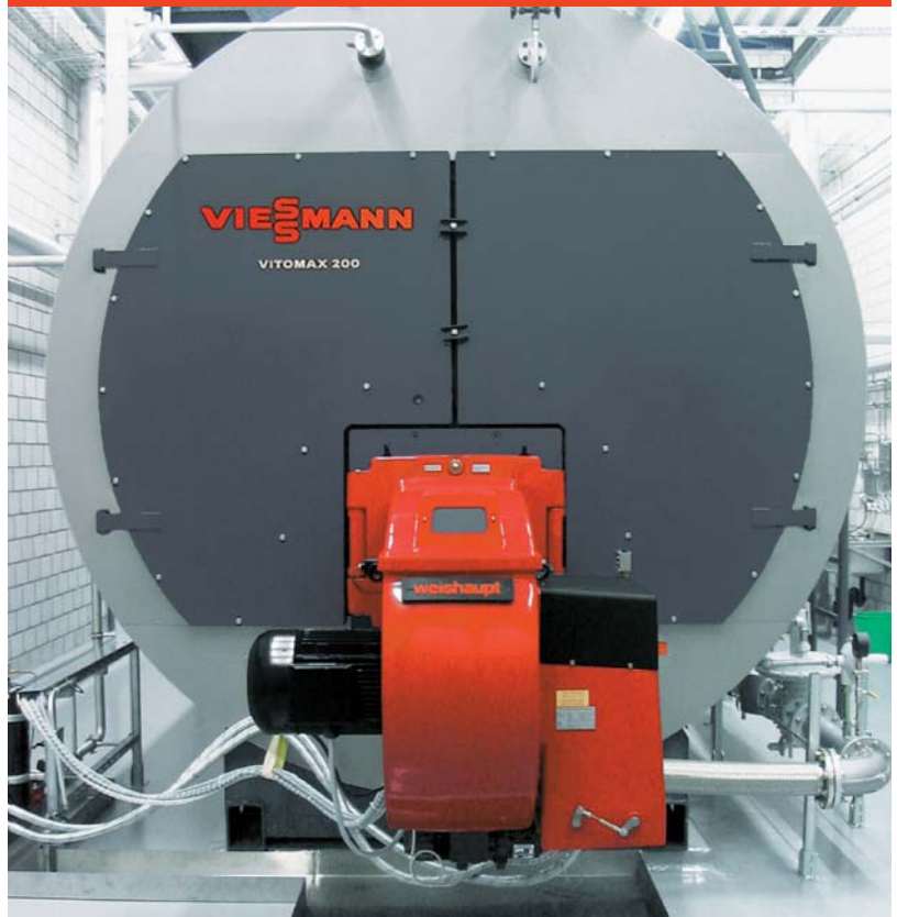
Abb. C.4.4-2 Vitomax 200-HS mit Ölbrenner
