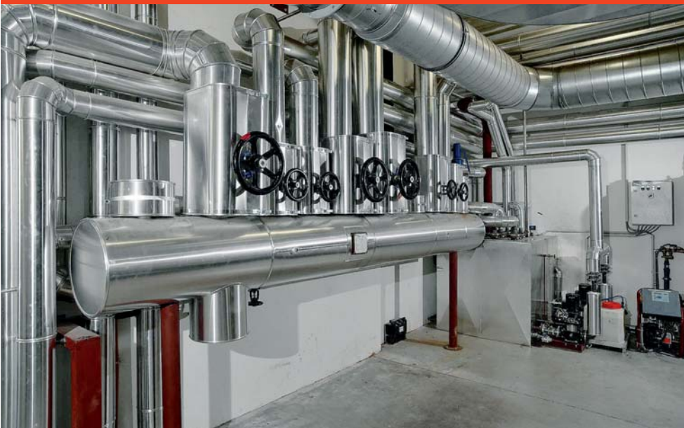
Abb. C.9.1-2 Dampfverteiler
