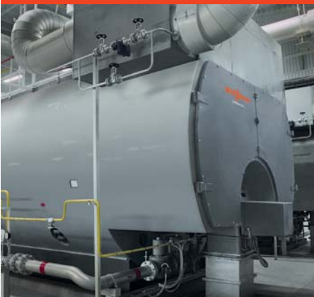
Abb. D.2.3.4-5 Dampfkessel mit Überhitzer
