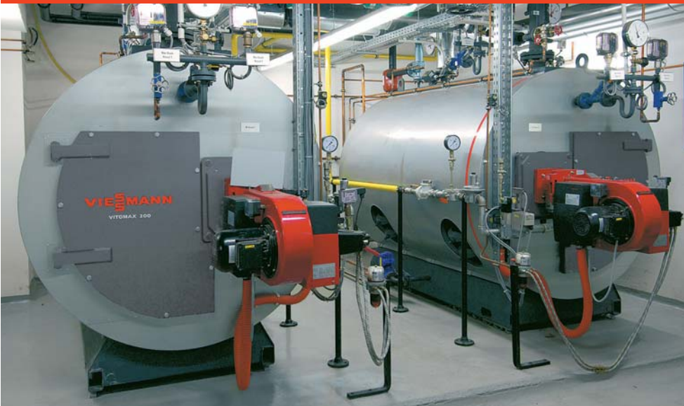
2 Vitomax 200-HS Typ M237 gespiegelte Ausführung
