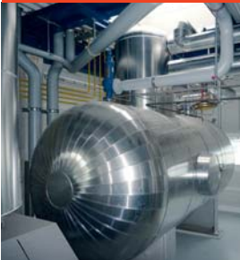
Thermische Vollentgasungsanlage
