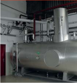
Thermische Vollentgasungsanlage
