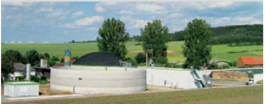
Erweiterung der vorhandenen Biogasanlage in Wettesingen mit einem BHKW.
