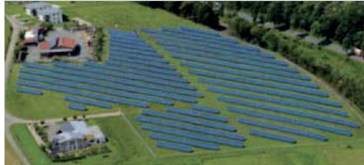
Photovoltaik-Anlagen können die Stromerzeugung mit Kraft-Wärme-Kopplung sinnvoll ergänzen.
