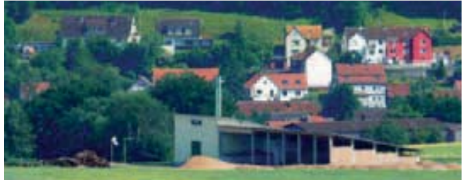
Das Biomasse-Heizwerk in Oberrosophe liefert Wärme für mehr als 450 Einwohner.
